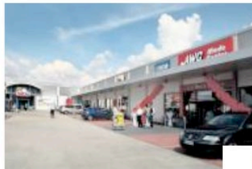
Zügig gebaut. Im Oktober 2012 war der erste Spatenstich gesetzt worden. Foto. A. Koska
